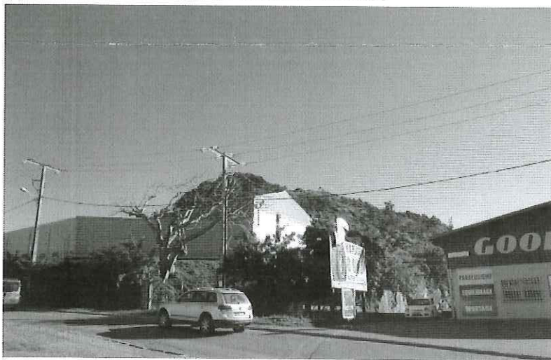
Lignes électrique et OPT aériennes le long de la rue Auer
