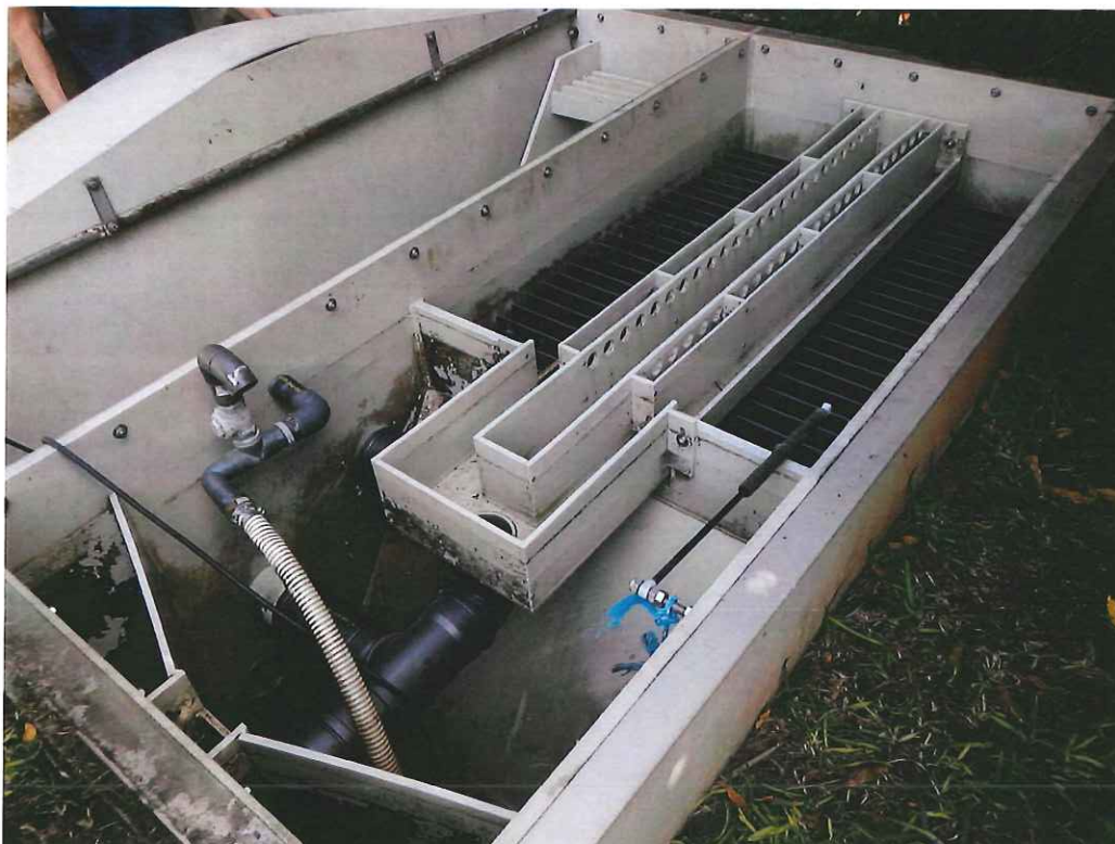
Figure 3 : clarificateur lamellaire à l'arrêt
