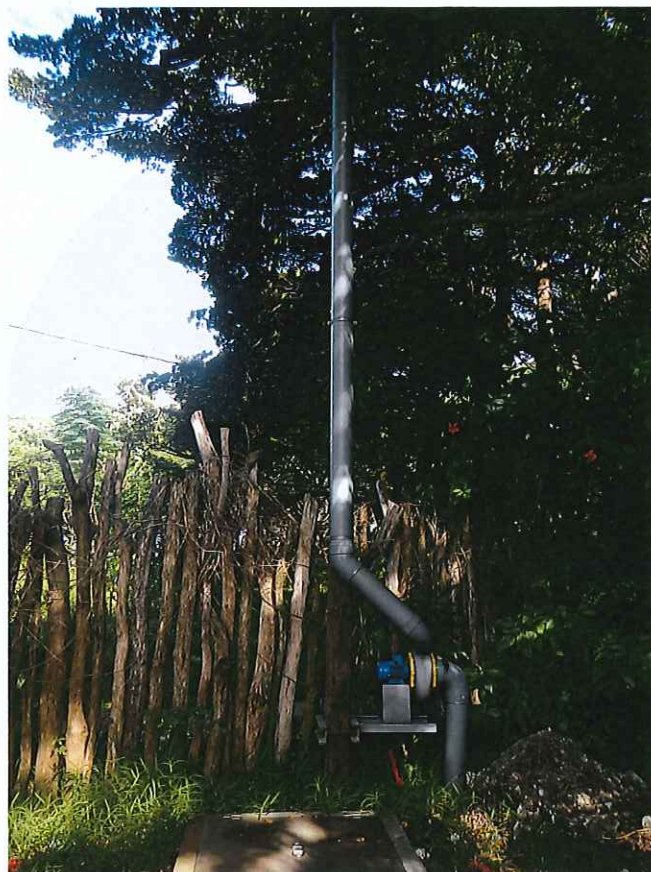
Figure 1 : dispositif de captage des odeurs au niveau du poste de relevage situé en amont de l'ouvrage de traitement
