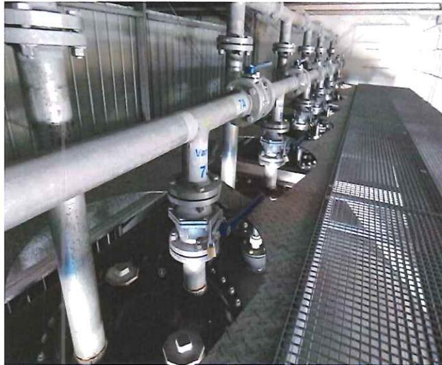
*Photo 1 : Ligne de remplissage au-dessus des cuves présentant les vannes cadenassées de chaque cuve*
