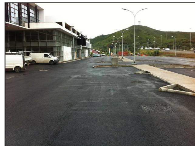
Station de traitement totalement enterrée et invisible Projet PLEXUS (350 EH) – Nouméa – Nouvelle-Calédonie
