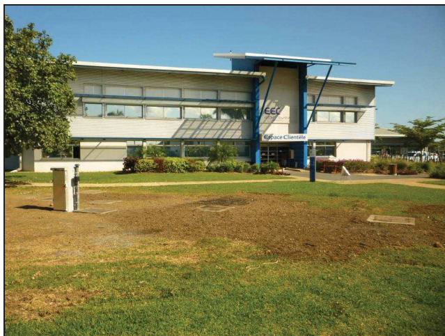
Station de traitement totalement enterrée et invisible EEC (75 EH) – Nouméa – Nouvelle-Calédonie
