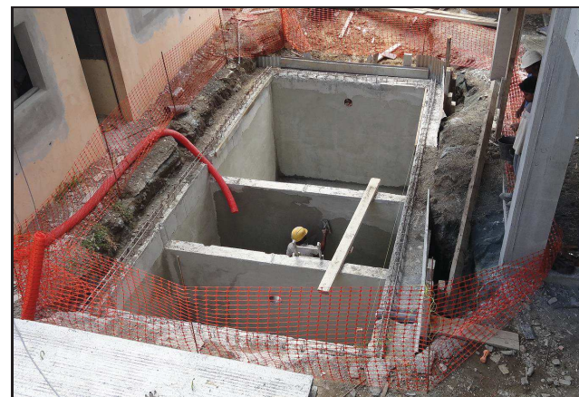
Station de traitement en cours de construction (sous parking) Résidence TAMAHERE (85 EH) – Nouméa - Nouvelle-Calédonie
