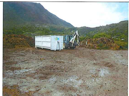
Plateforme de broyage des déchets verts avec déchets verts à broyer à droite et broyats à gauche en cours de transvasement dans la benne de stockage
