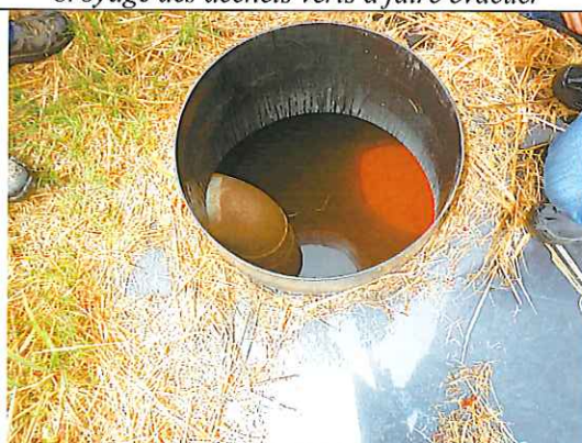
Effluents contenus dans la cuve de récupération des lixiviats
