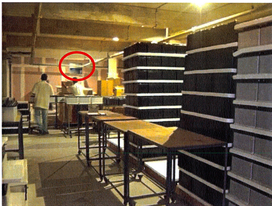
Image 16 – Exutoire des fumées du local de stockage des polymères
