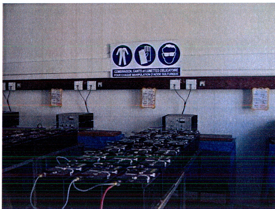
Images 19 et 20 – Batteries en cours de chargement dans le local de charge des batteries
