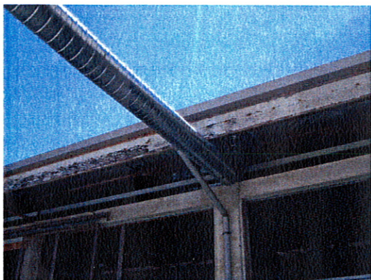
Images 5 à 8– Installation de ventilation du bâtiment de stockage de l'acide et de l'électrolyte
