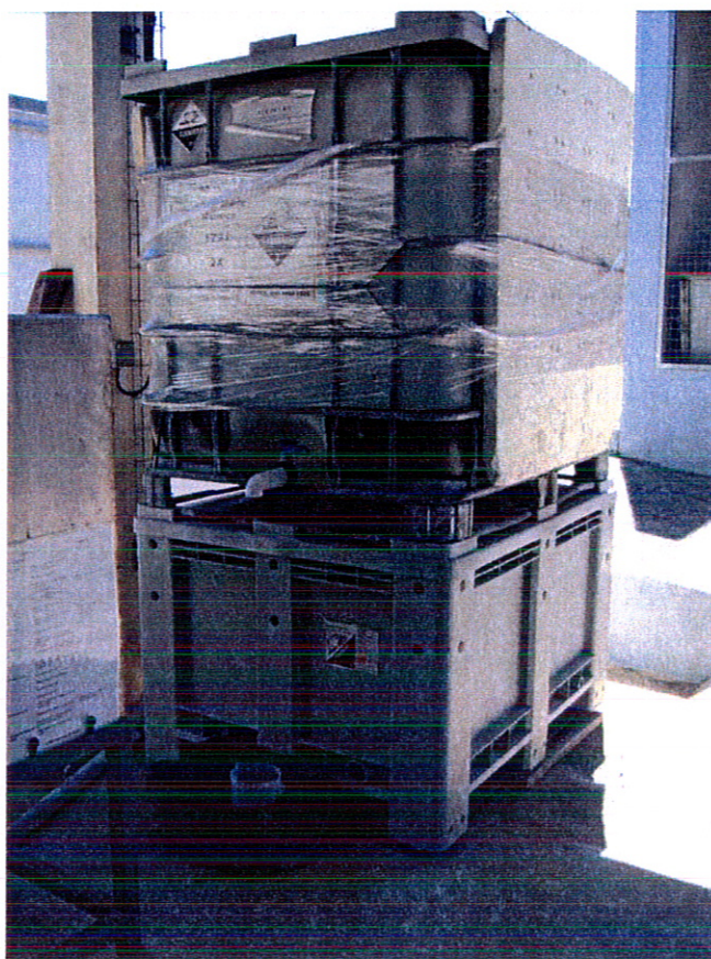
Image 4 – Installation de stockage de la soude de l'unité de neutralisation des effluents
