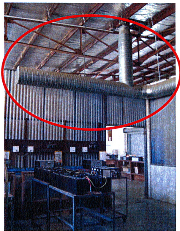
Image 9 – Installation de ventilation du local de charge des batteries
