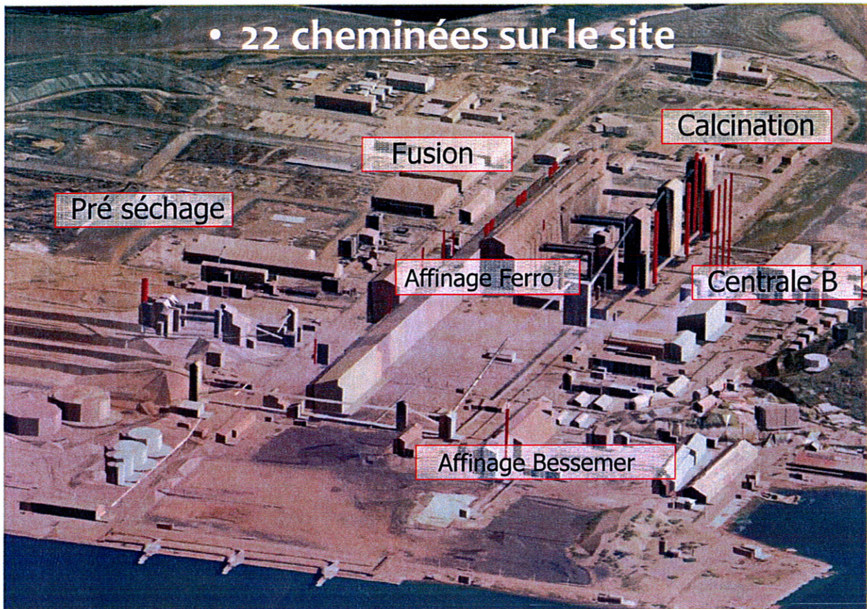
Points de rejets canalisés filtrés
