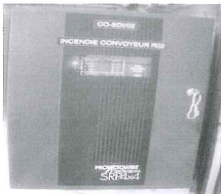
Le convoyeur est équipé d'un câble de détection géré par la centrale SRP 4x4. Cette centrale permet de situer le départ de feu en indiquant la distance entre le début du convoyeur et le lieu du sinistre via un écran digital situé sur la face avant.
