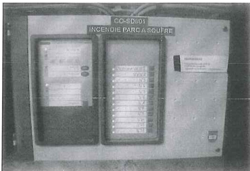
Les détecteurs sont, via le coffret de regroupement situé au niveau de la trémie de chargement, connectés à la centrale BC1112 située salle électrique P7.
