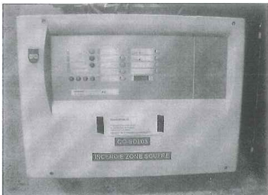
Cette centrale d'extinction autonome, compacte est conforme aux normes EN 54-2, EN 54-4 NF - MIC n°ECS-018-B0. Cette centrale gère toute la partie détection des deux installations ainsi que les affiches lumineuses et les diffuseurs sonores.
