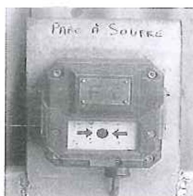
Ce bris de glace a été conçu pour être utilisé en atmosphère explosive, et en conditions atmosphériques difficiles. Il est antidéflagrant.
