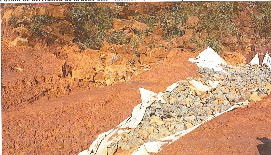
Photo 6 : Drain de dérivation de la zone dite "cascade" (versant Sud) - vue aval
