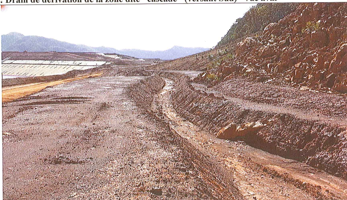
Photo 6 : Drain de dérivation de la zone dite "cascade" (versant Sud) - vue aval
