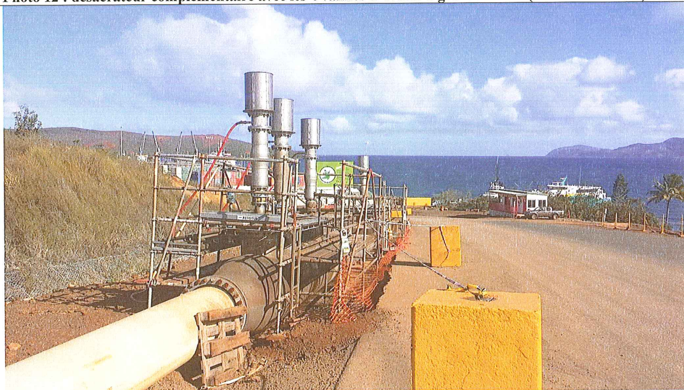
Photo 12 : désaérateur complémentaire avec les 4 vannes d'évents à grands débits (PRV 0060 à 0063)
