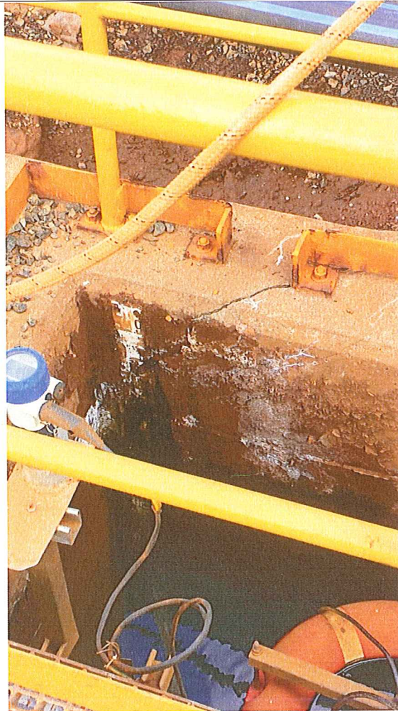
Photo 11 : fissure au niveau du puits de pompage
