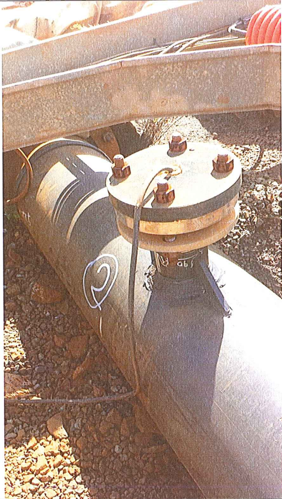
Photo 10 : piquage du conductivimètre du drain 2
