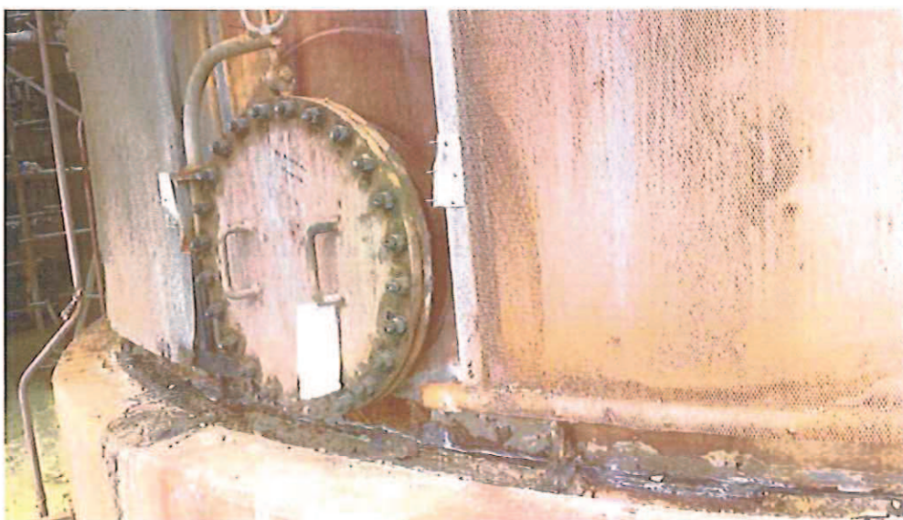
Photo 9 : ancien échangeur de chaleur en serpentín hélicoïdal
