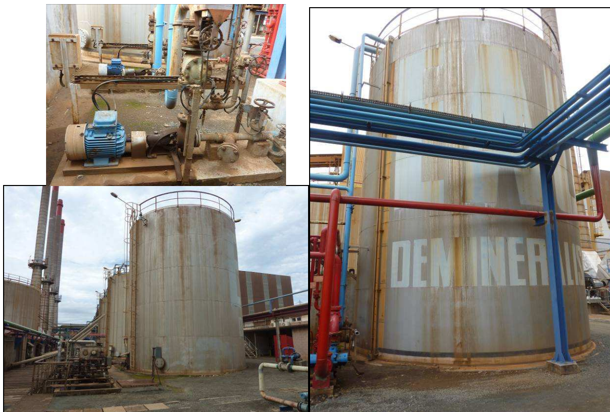
Réservoirs d'eau brute, d'eau déminéralisée, et pompes de transfert d'eau.
