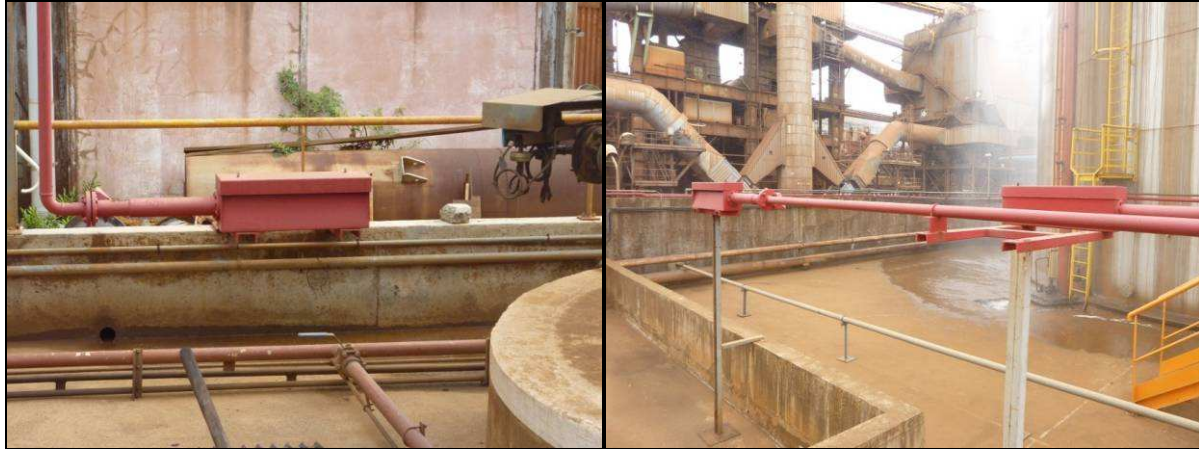
Déversoirs à mousse dans les cuvettes des réservoirs de fuel lourd.
