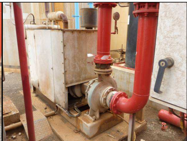
Pompe incendie diesel en secours
