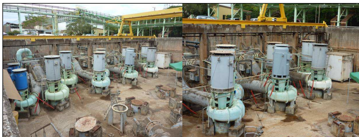
Station de pompage eau de mer ; à gauche en bleu roi les pompes MPREM 1/2 alimentant les réfrigérants. En gris les pompes MPC 11/12, 21/22, 31/32, et 41/42 alimentant les condenseurs des quatre tranches.
