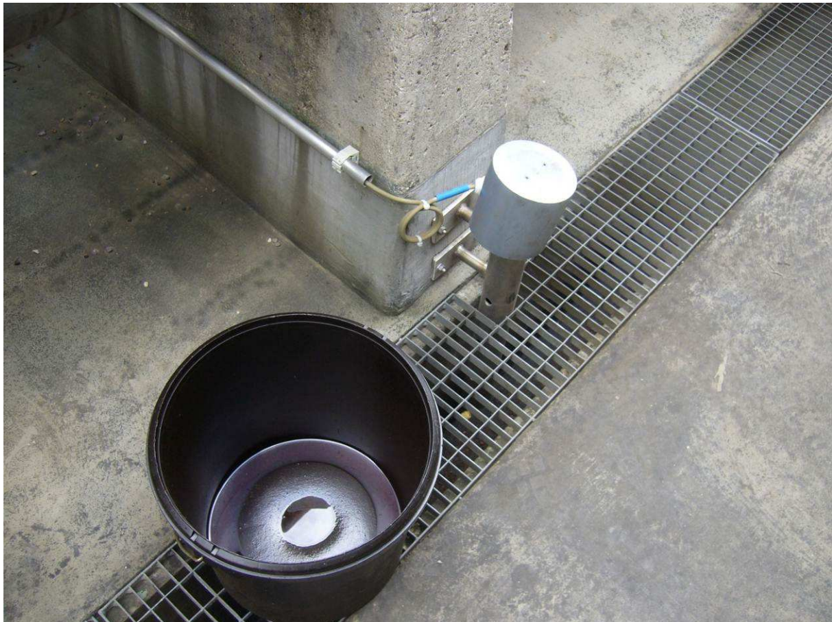
Détecteur d'hydrocarbures liquides à lame vibrante immergée en cuvette de rétention .
