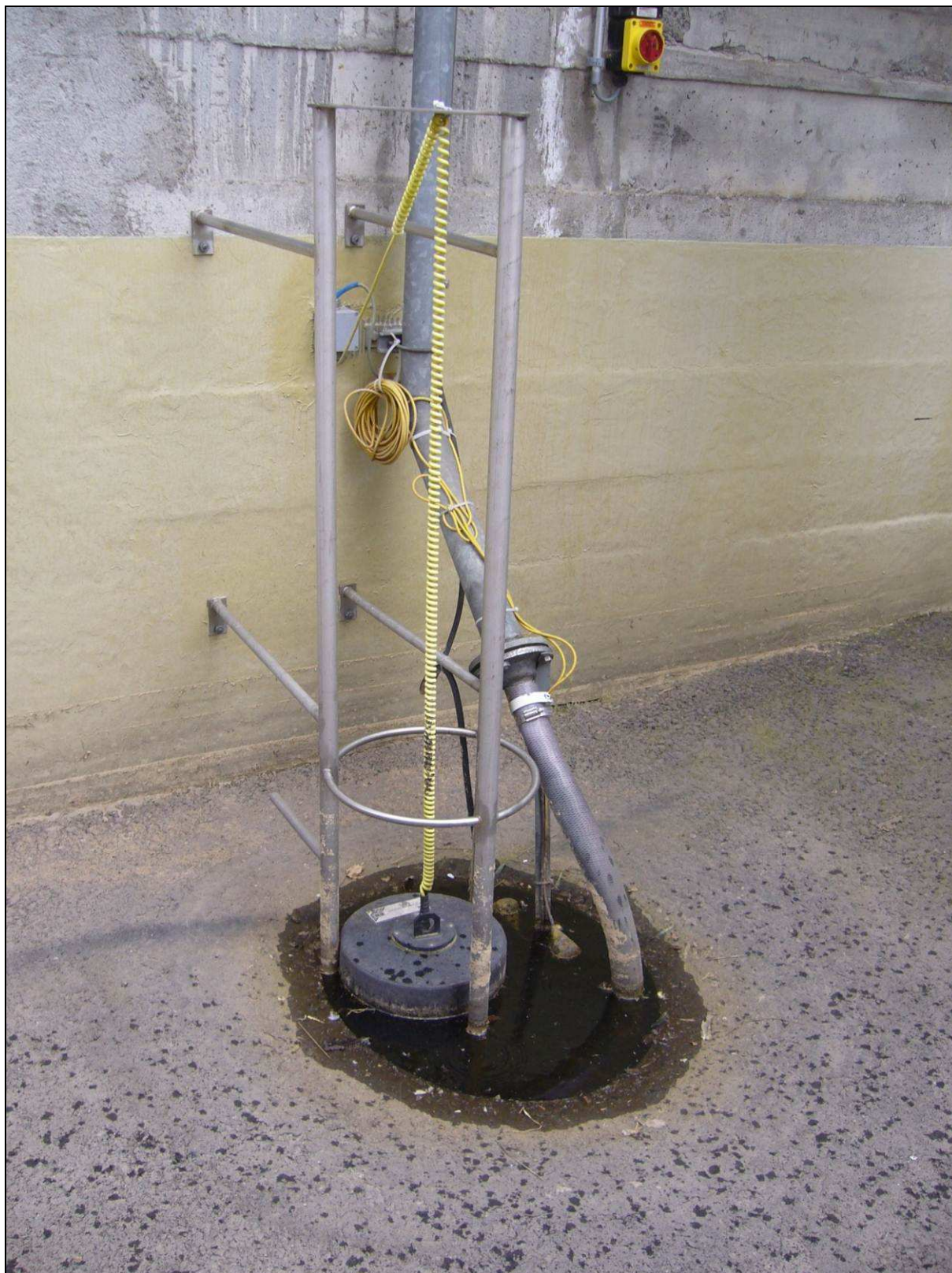
Détecteur hydrocarbures liquides par film d'hydrocarbures
