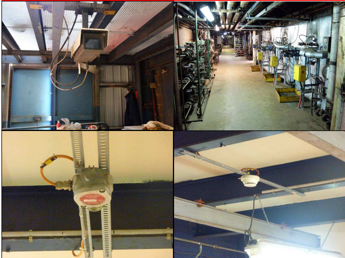
Différents types de détection : Caméra, vapeur, fumées
