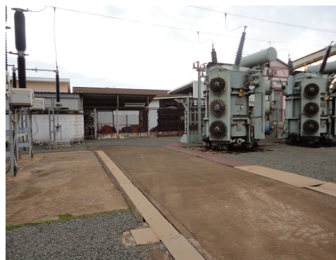
Transformateurs – Poste 150 kV
