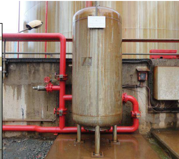
Réservoir d'émulseur
