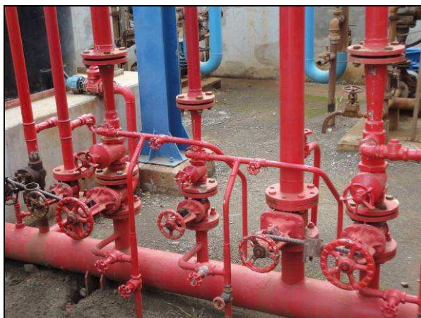
Manifold de répartition du prémélange
