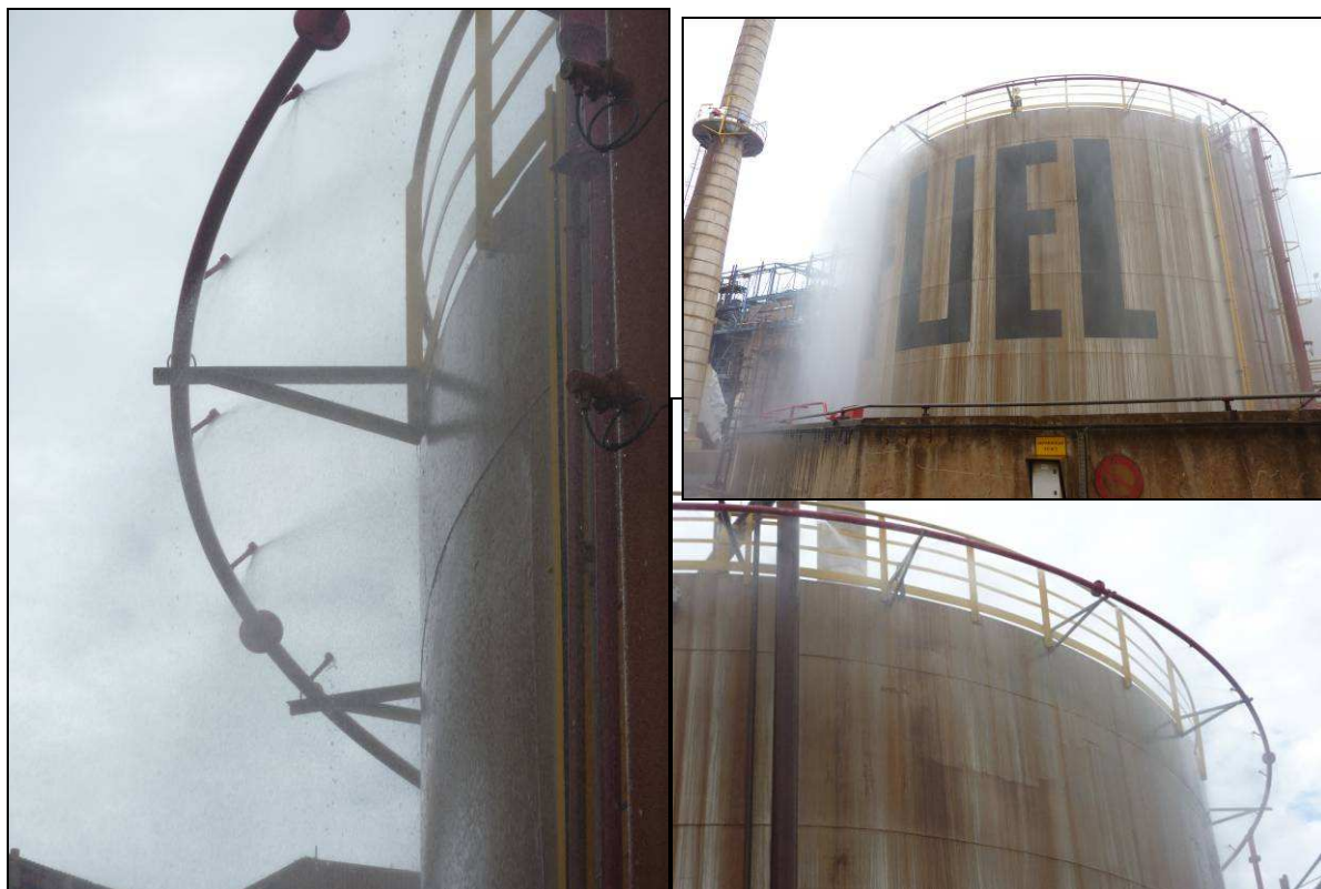
Essai d'arrosage de refroidissement des bacs de fuel lourd
