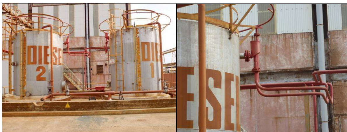
Couronnes de refroidissement et boîtes à mousse des bacs de gazole.
