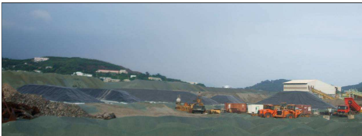
Photo 2 : Alvéoles réalisés pour le confinement des scories calcosodiques
