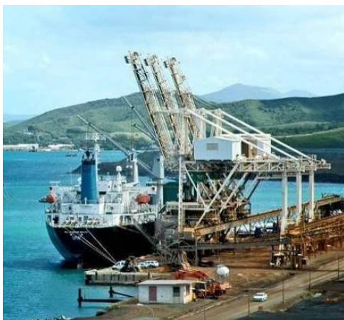
Minéraliers & portiques de déchargement dit « Portiques Caillard »
