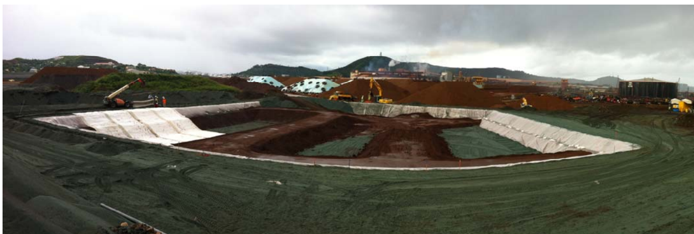
Mise en place du géosynthétique bentonitique (bassin d'huiles)
