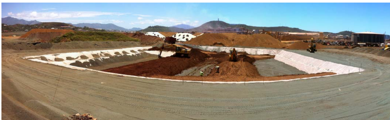
Recouvrement du géosynthétique bentonitique (fins des travaux d'étanchéité)
