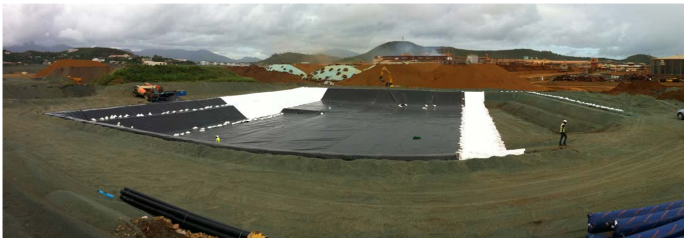
Mise en place de la géomembrane PEHD inférieure 1.5mm
