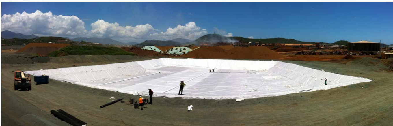
Mise en place du géotextile de protection supérieur 600g/m 2 et des drains
