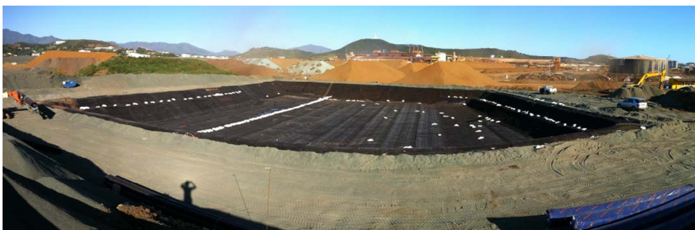
Mise en place des capteurs et de la géogrigle de drainage
