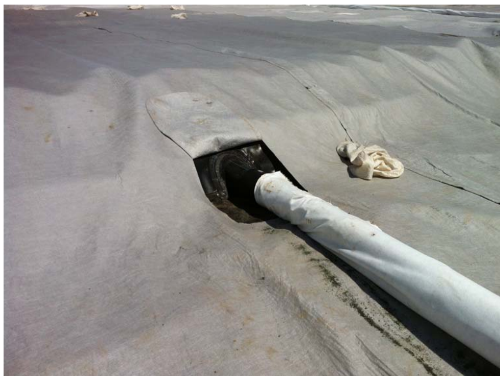
Mise en place des drains
