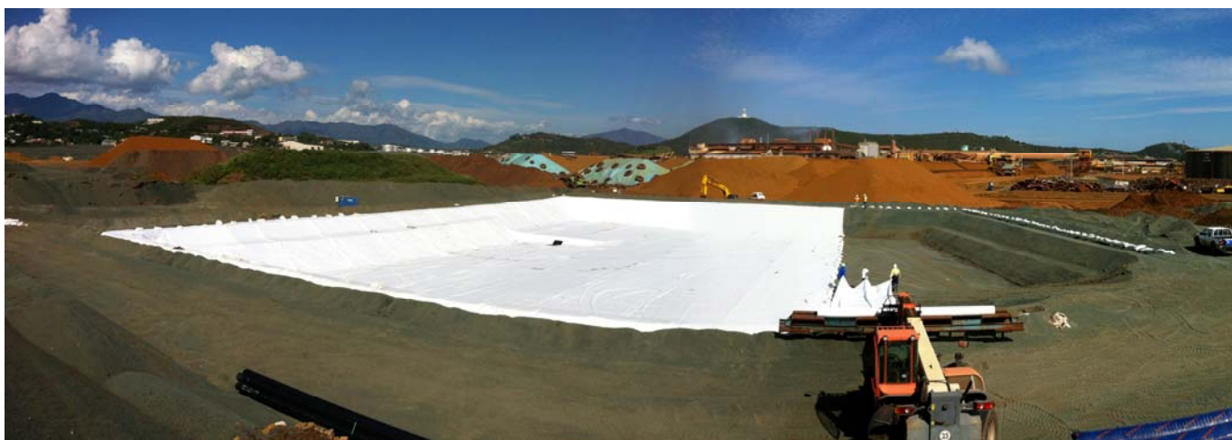
Mise en place du géotextile de protection inférieur 300 g/m 2
