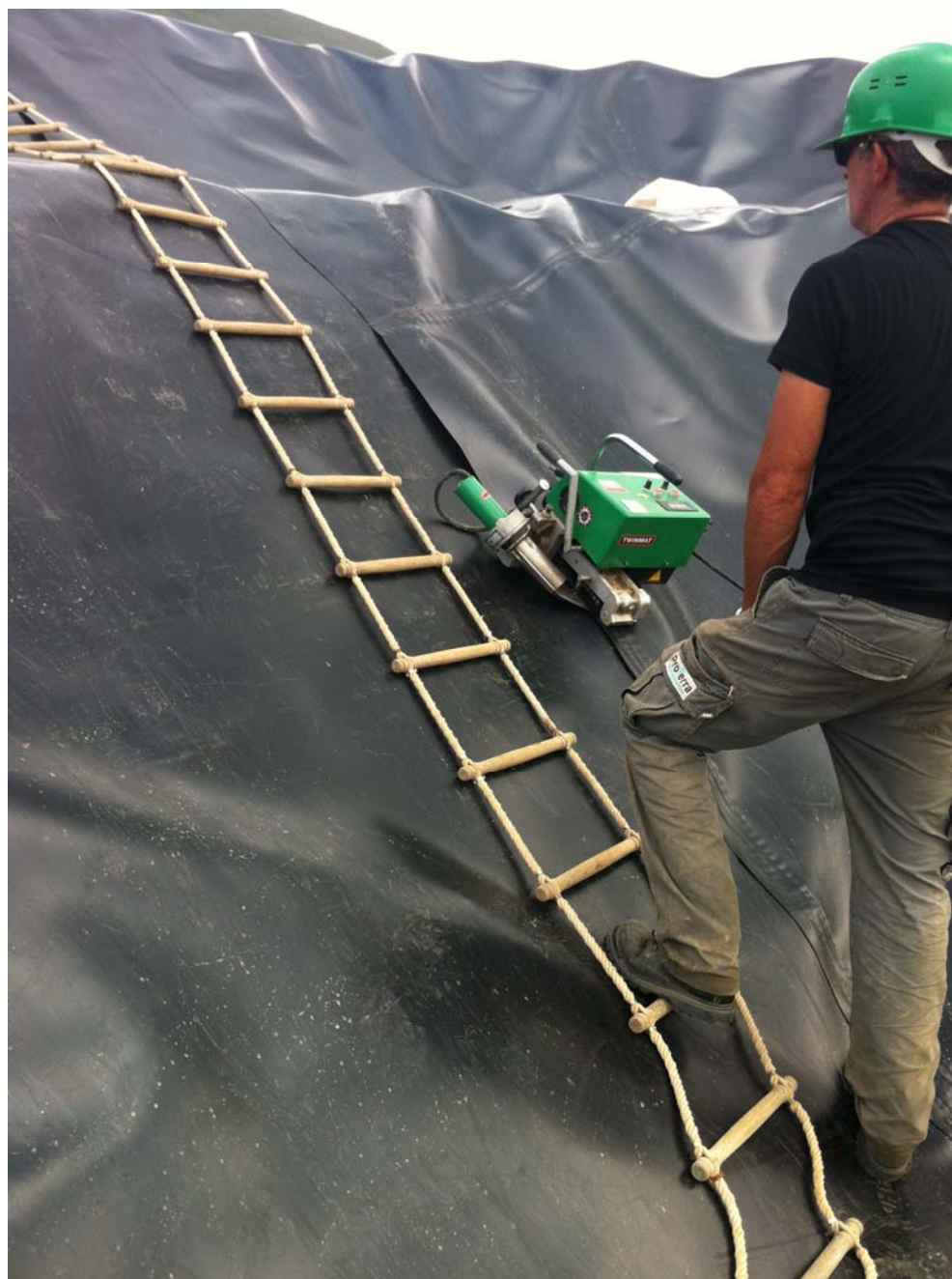
Soudure de la géomembrane
