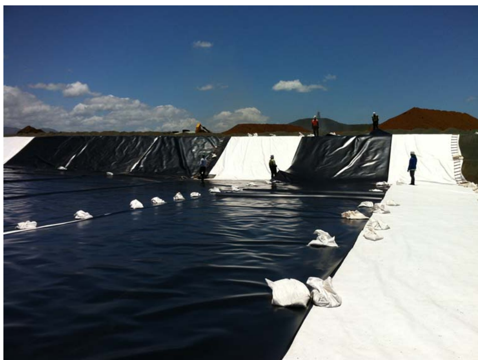
Pose des lés de géomembrane
