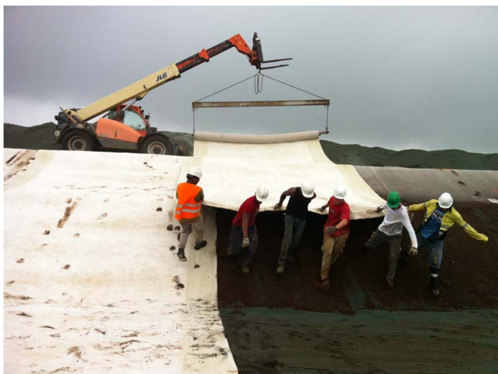
Mise en place du géosynthétique bentonitique
