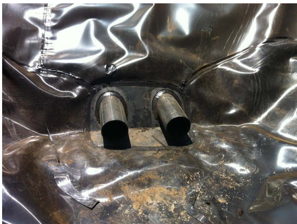
Soudure des pénétrations
