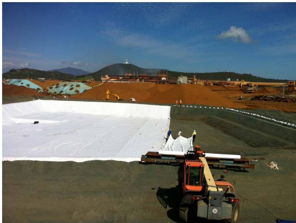
Pose des lés de géotextile
