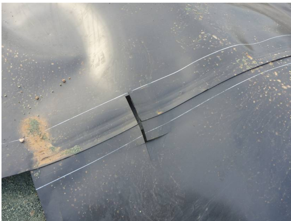
Prise d'échantillon de contrôle destructif des soudures (doubles soudures à canal central)
