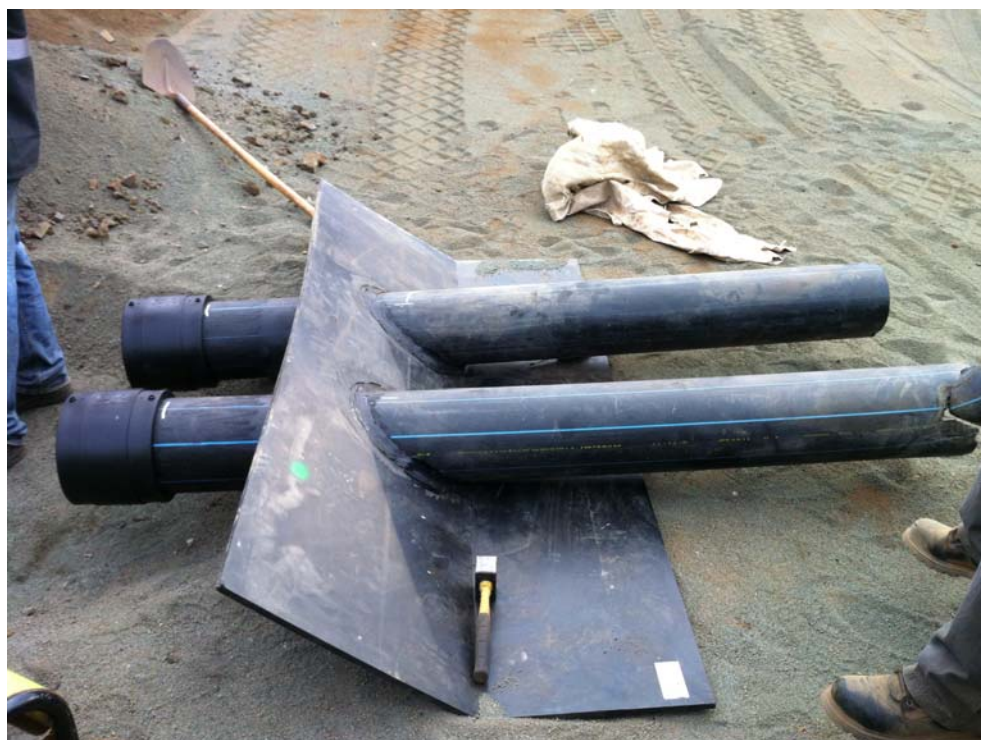
Préfabrication des pénétrations
