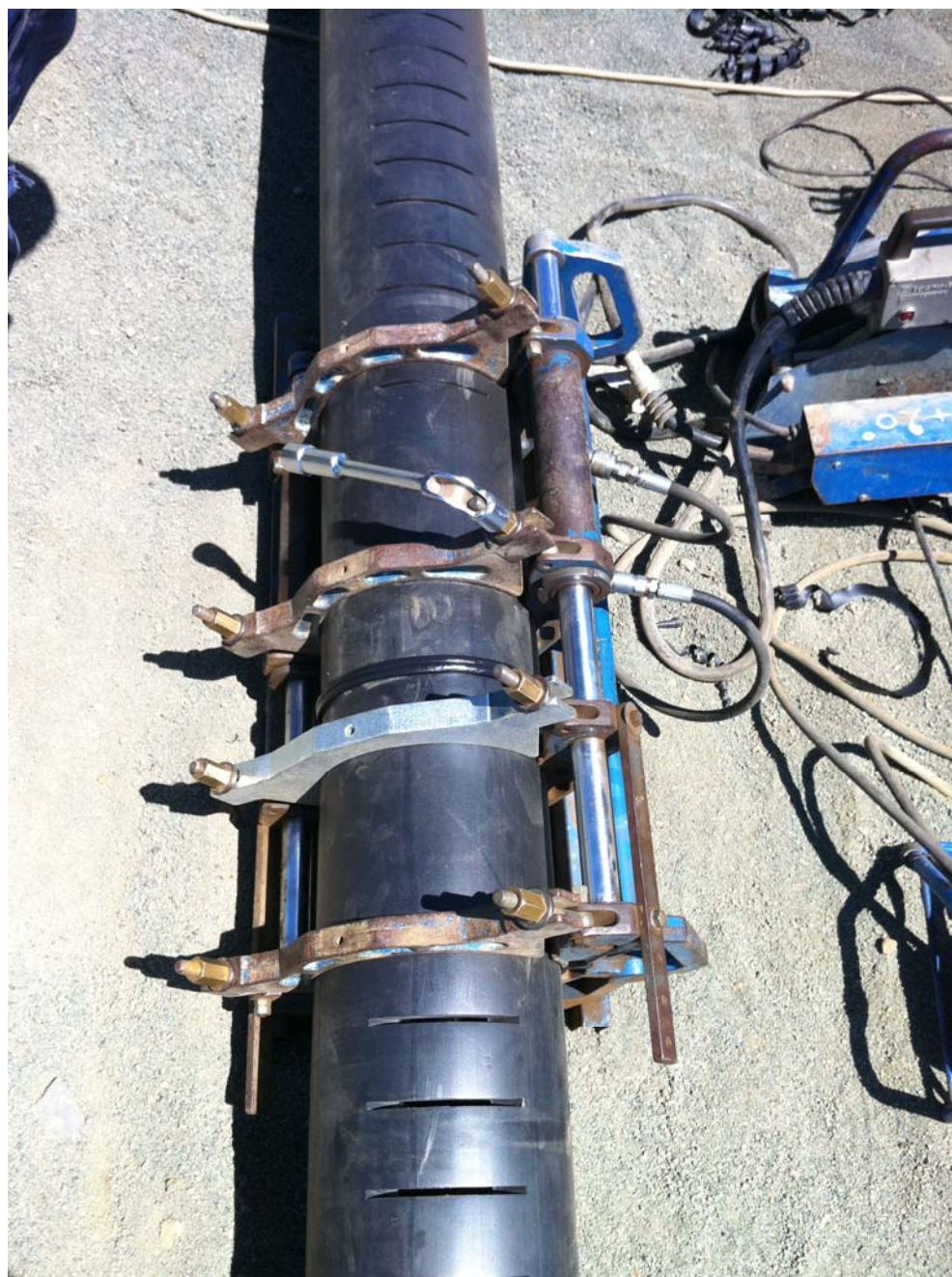
Soudure des drains
