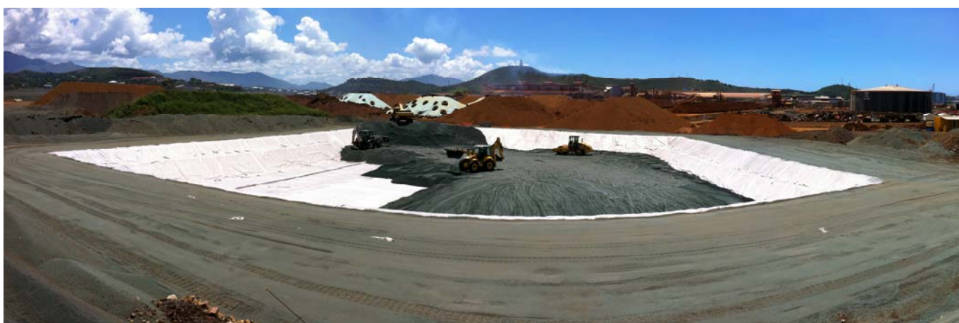
Mise en place de la couche de protection de scorie de fusion
