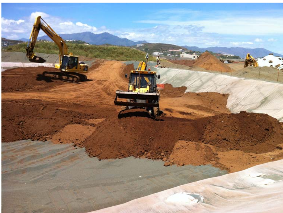
Mise en place du recouvrement
