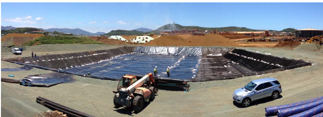
Mise en place de la géomembrane PEHD supérieure 1.5mm
