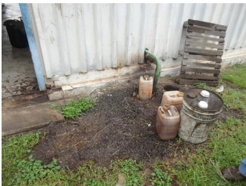
**Figure 9 : Pollution autour du robinet de purge du compresseur de l'usine d'acétylène**
