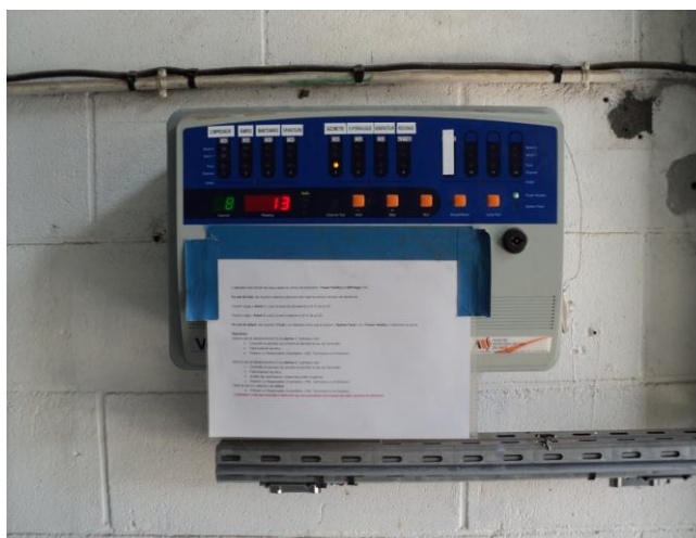
Photo 5 : Centrale de détection acétylène, acétone
