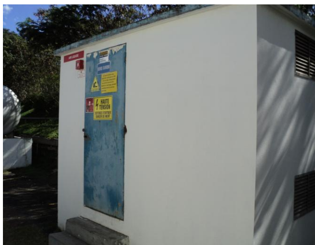
Photo 2 : Poste de transformation HT/BT 250 kVA à l'intérieur du site
