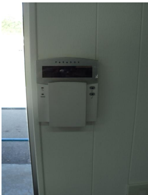
Photo 4 : Centrale de détection intrusion des bureaux administratifs
