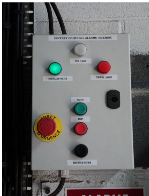
Photo 6 : Centrale incendie manuelle usine acétylène
