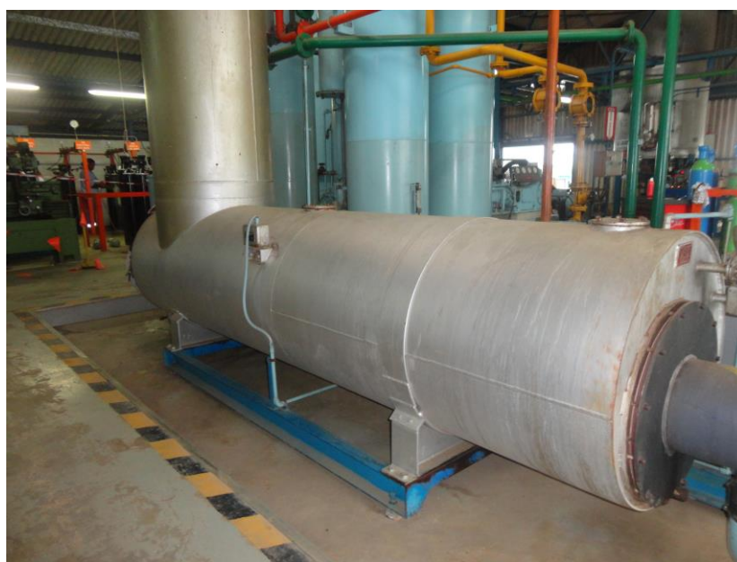
Photo n°4 : Cuve de stockage de 1000 litres de solution de permanganate de potassium
