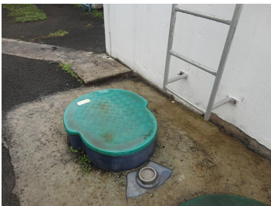
Photo n°2 : Séparateur et trappe de prélèvement
