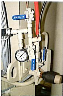
Régulation thermostatique pour le circuit de refroidissement (OPTION)
