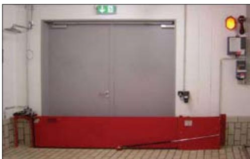
En position de repos, la barrière se trouve perpendiculaire au sol. Elle est tenue dans sa position verticale par un électro-aimant.
