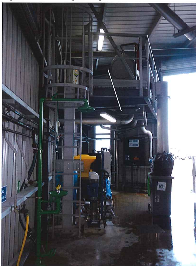
Photo 6 : Plateforme des prétraitements et ses garde-corps
