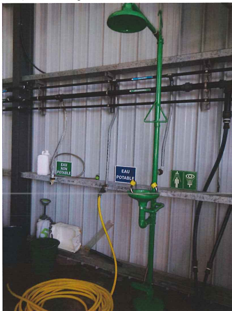
Photo 4 : Douche de sécurité, rince-oeil et signalement des réseaux d'eaux
