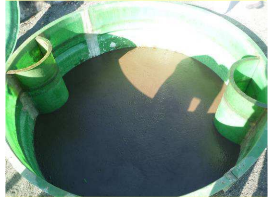
Silo à boues
