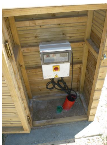
Armoire de commande KSB
