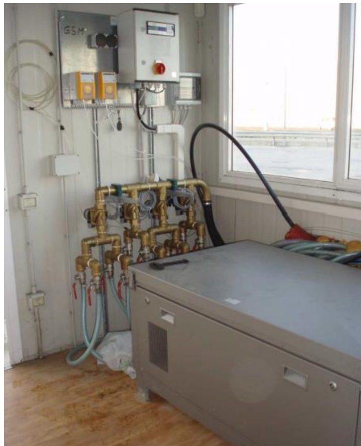
Local technique comprenant le tableau de commande, le compresseur d'air + boîte insonorisée et le distributeur d'électrovannes
