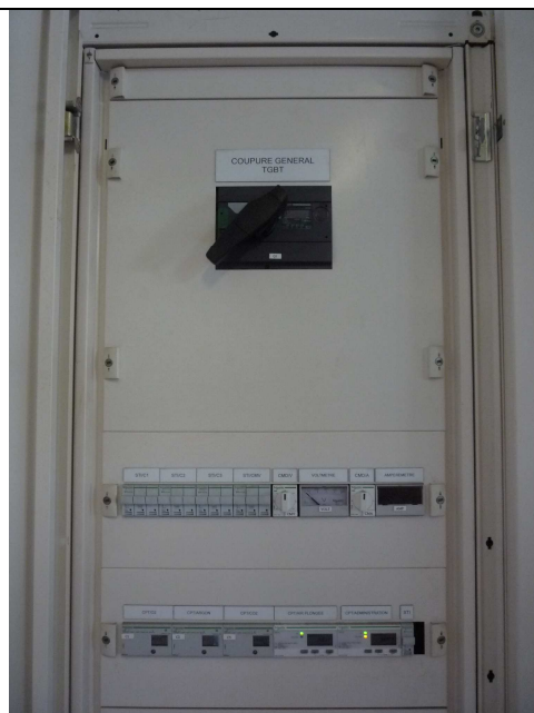
Coupure générale au TGBT Bâtiment principal
