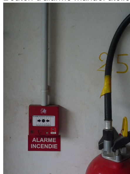
Bouton d'alarme manuel dépôt gaz conditionné
