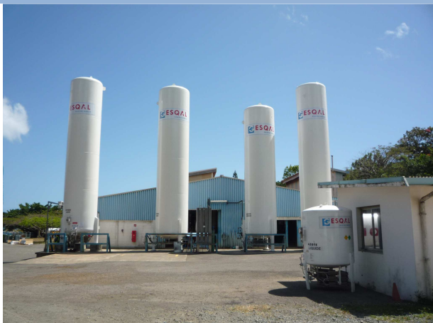
Réservoirs Oxygène x 2, Dioxyde de Carbone, Argon
