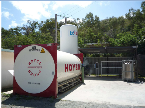
Réservoir Azote liquide 6,4 T et iso-tank Azote
