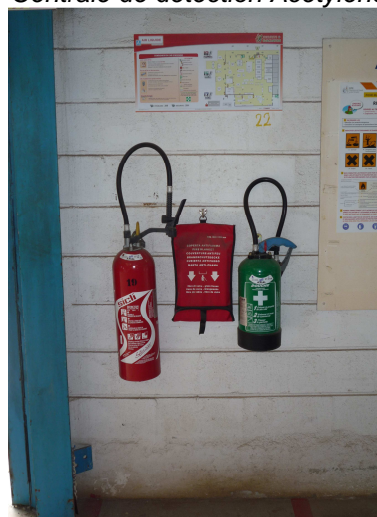
Extincteur, couverture et douche portative à l'atelier
