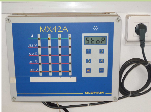
Centrale de détection laboratoire
