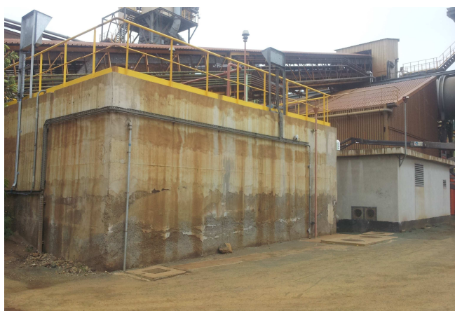
Nouveau dépôt (semi-enterré) avec le nouveau local pomperie
