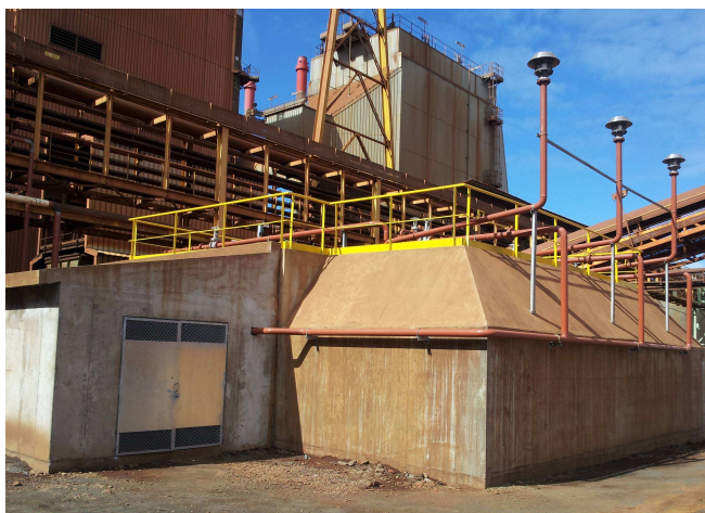
Nouveau dépôt (semi-enterré).
