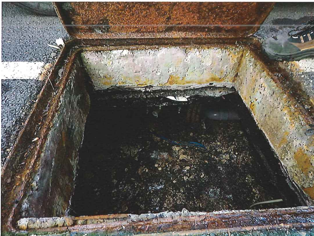
Photo 3 : Bassin d'accumulation des effluents
