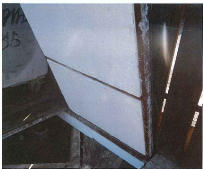
Photo 5 : Isolation au niveau du bassin aération/décantation
