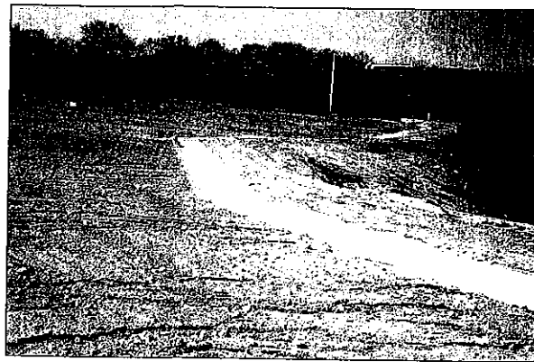
Fossé interne d'interception des eaux de ruissellement sur la couverture finale
