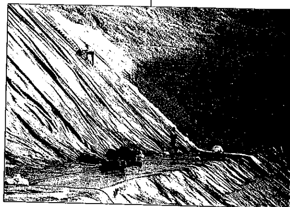
Opération de soudure de la géomembrane
