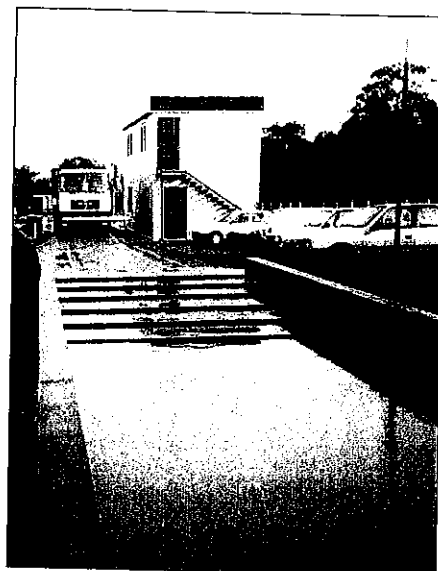
Débourbeur pour le nettoyage des roues des véhicules
