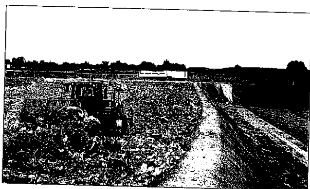
Compactage des déchets dans une alvéole séparée par un merlon de l'alvéole suivante
