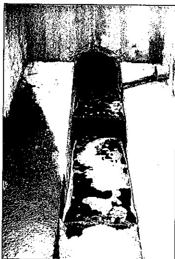
Sortie gravitaire de lixiviats d'un drain d'une alvéole
