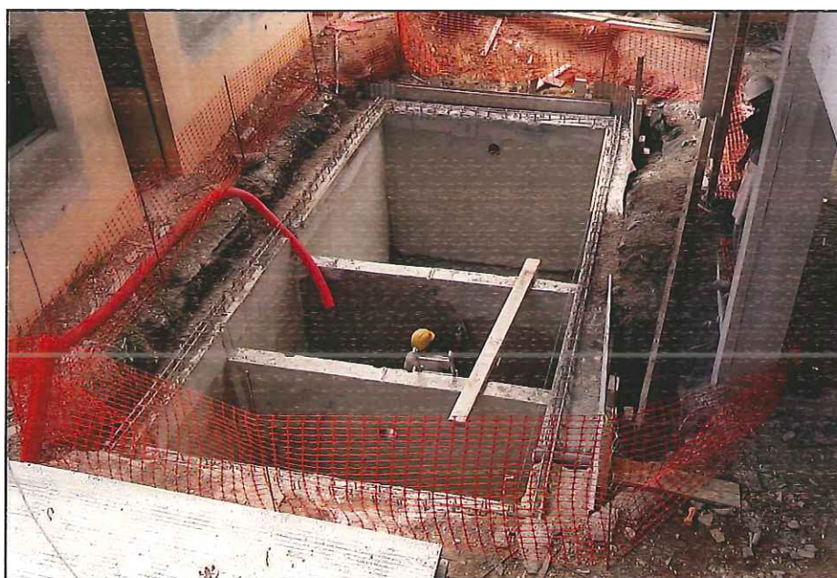
Station de traitement en cours de construction (sous parking) Résidence TAMAHÉRE (85 EH) – Nouméa - Nouvelle-Calédonie
