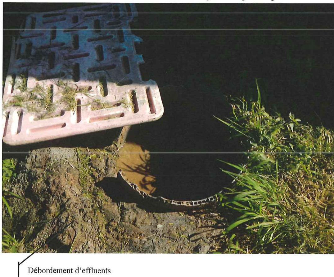
Photo 6 : Regard du réseau de collecte des effluents endommagé et chargé de dépôts
