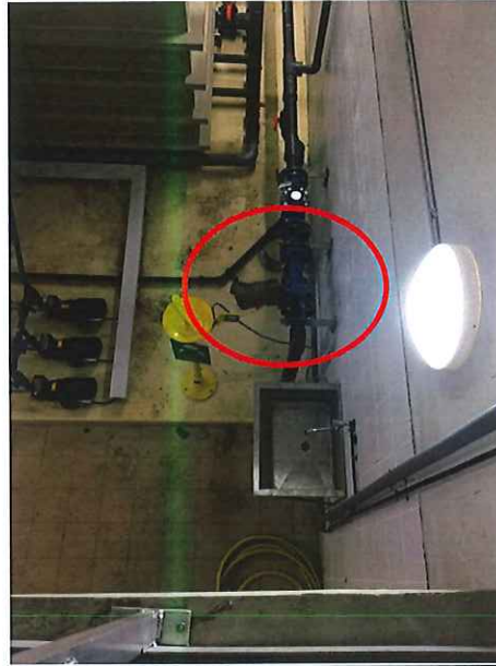
Photo 34 : Fuite dans l'atelier boues à identifier
