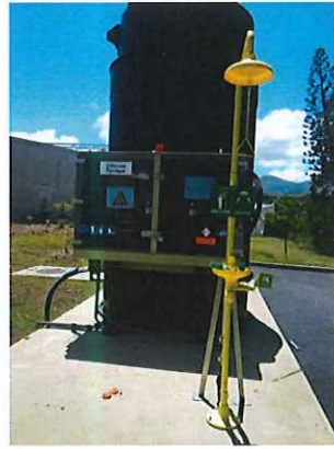
Photo 18 : Cuve de chlorure ferrique pour la filière eau, douche et rince œil
