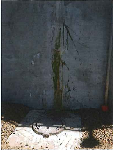
Photo 17 : Fissure colmatée du bassin d'aération
