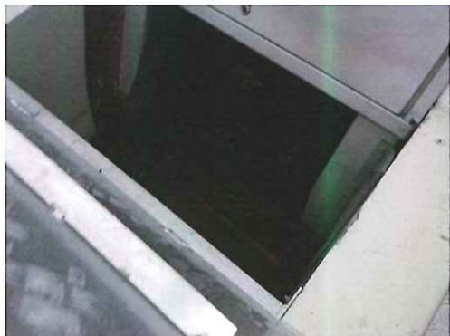
Photo 13 : Arrivée des refus de dégrillage en ensachage
