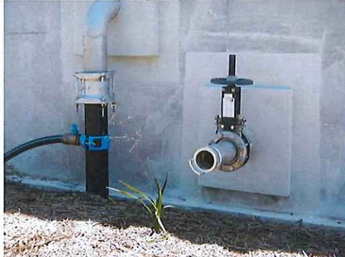
Photo 23 : Raccord pompiers sur le clarificateur
