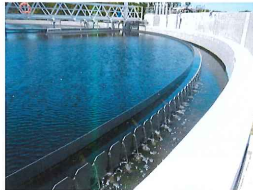
Photo 22 : Canal de rejet des effluents avec sonde débitmétrique
