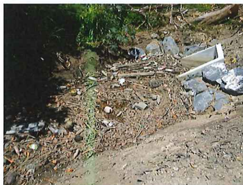
Photo 6 : Sortie du trop plein recouverte de déchets
