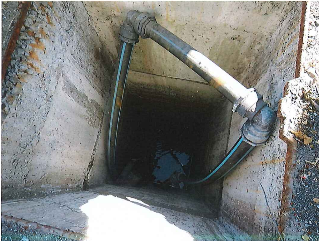
Photo 5 : poste de refoulement
