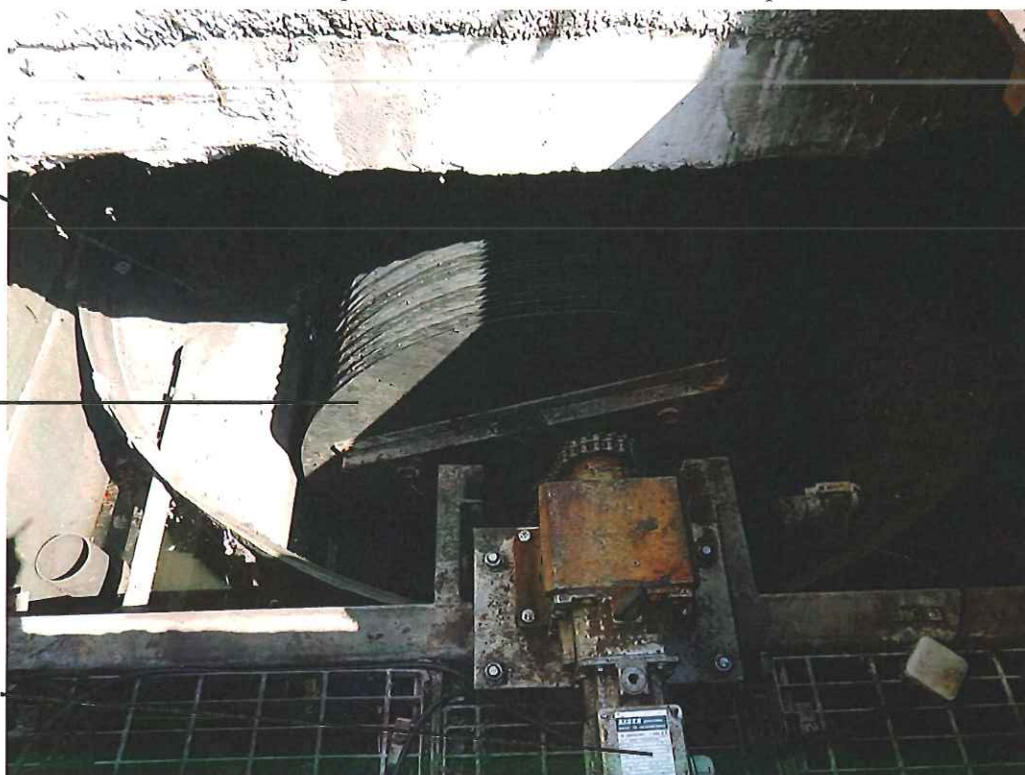
Photo 3 : accès à la zone 2 du biodisque et absence de biofilm sur les disques de la zone 2
