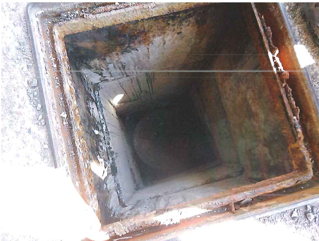
Photo 4 : tampon d'accès au bac à graisse
