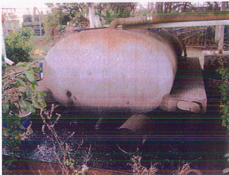
Image 4 – Cuve de stockage des huiles usagées et rétention associée : présence de résidus d'hydrocarbures, de terre et autres déchets
