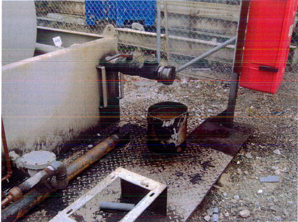
Image 1 – Bouche de dépotage de la cuve de kérosène avec sa rétention
