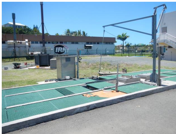
Figure 23 : Photo Soproner 2013 – Désinfection UV
