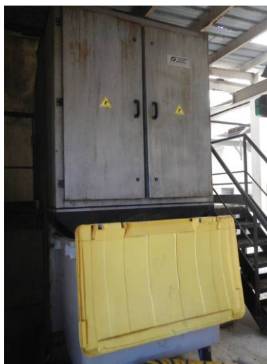
Figure 13 : Photo Soproner 2013 – Dégrilleur
