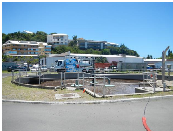
Figure 17 : Photo Soproner 2013 – Bassin d'aération (Filière 18 000 EH à gauche et filière 7 000EH à droite))
