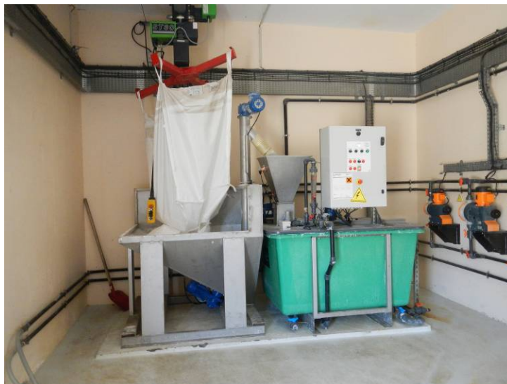
Figure 19 : Photo Soproner 2013 – Traitement des boues – Sulfate d'alumine
