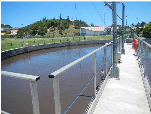
Figure 17 : Photo Soproner 2013 – Bassin d'aération (Filière 18 000 EH à gauche et filière 7 000EH à droite))
