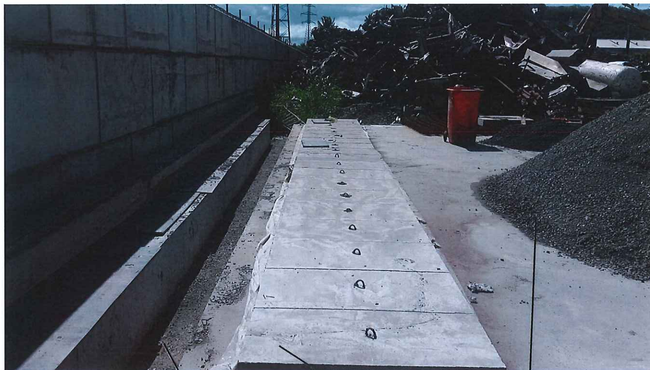
Photo 2 : dalles fabriquées pour recouvrir le caniveau à la périphérie Nord du site (vue en direction de l'Est)
