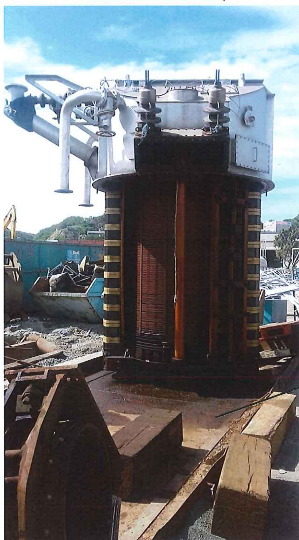
Photo 6 : égouttage d'un transformateur au niveau de la tranche 1A (vue en direction du Sud)
