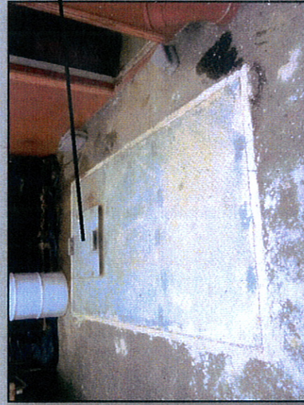
4. Cuve de stockage des huiles usagées (3000 litres, enterrée)
