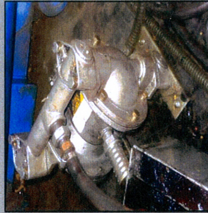
2. Electro-pompe permettant d'envoyer les huiles usagées dans la cuve enterrée
