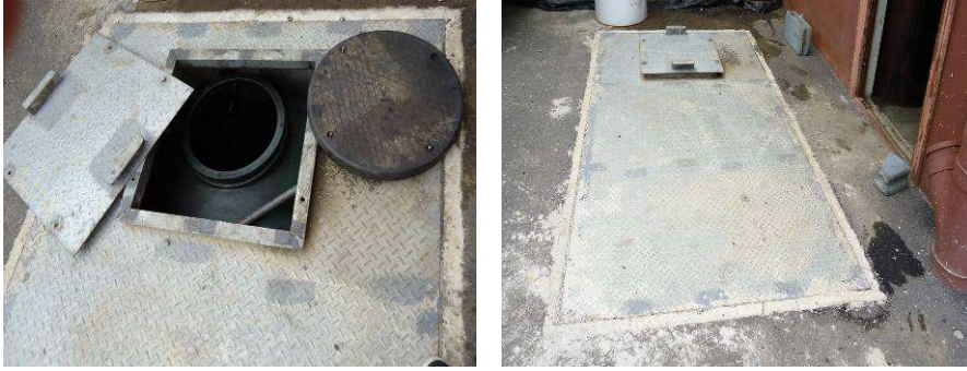
Figure 7. Cuve enterrée de stockage des huiles usagées (3000 litres).
