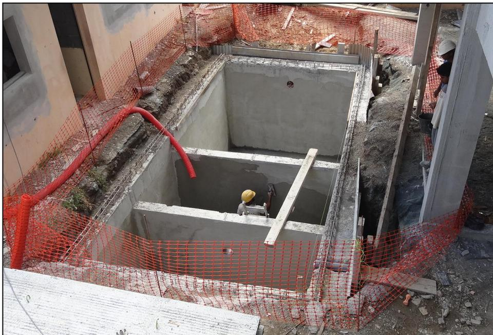
*Station de traitement en cours de construction (sous parking)*
