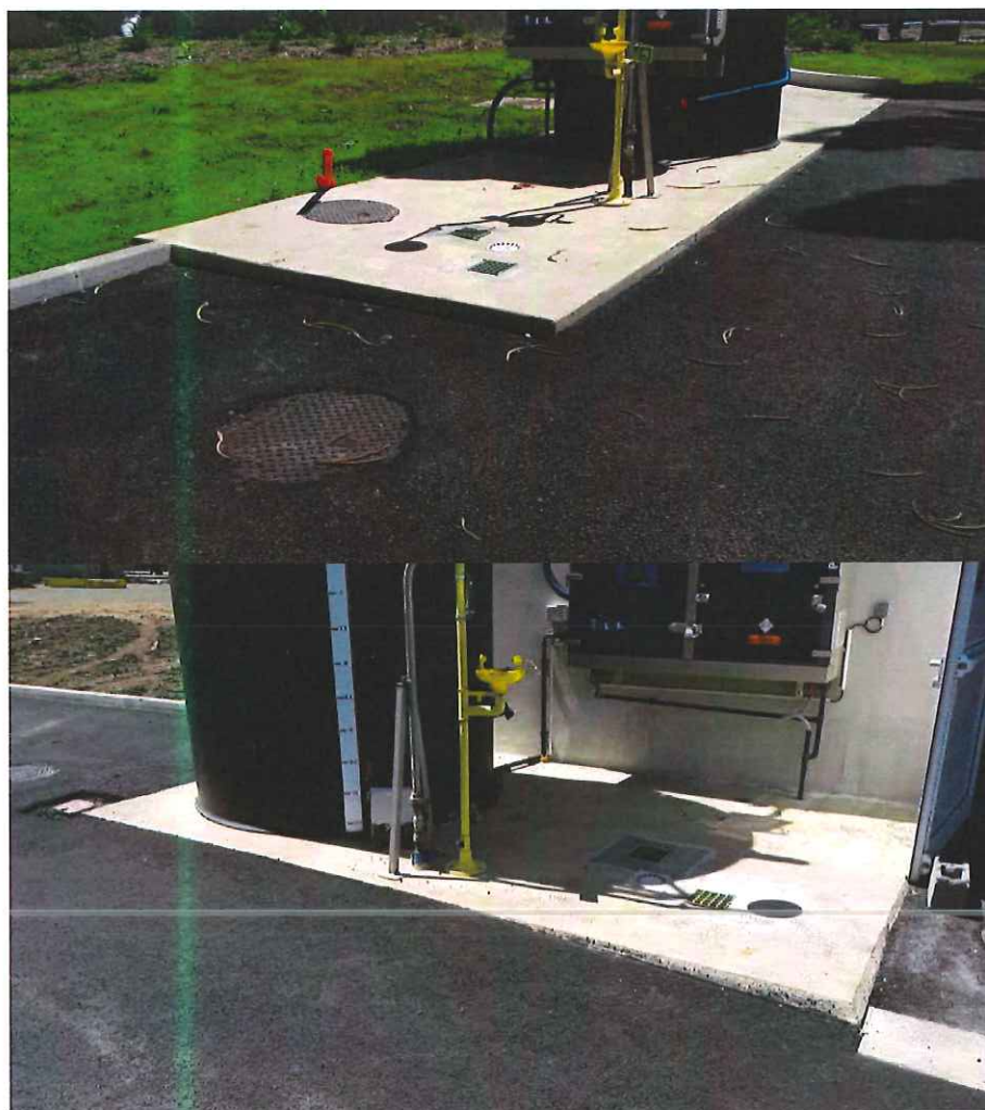
Figure 6 : Cuve de stockage de chlorure ferrique (file eau, en haut et file boue, en bas)
