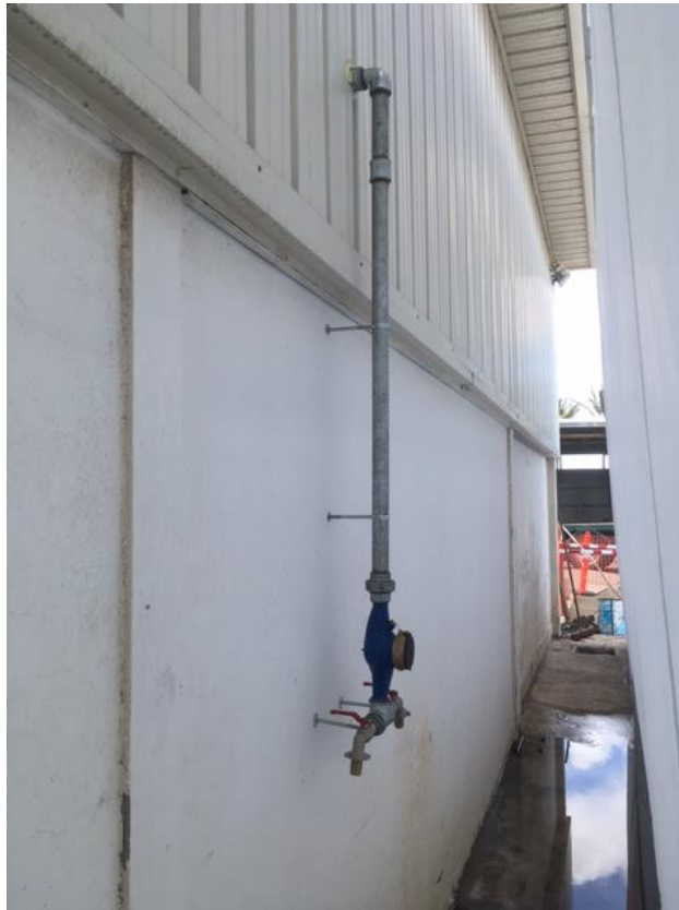
Arrivée d'eau avec deux sorties robinets servant à alimenter les deux nettoyeurs à haute pression
