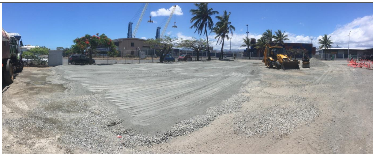
Pose de la couche de mortier maigre (épaisseur 2 cm)
