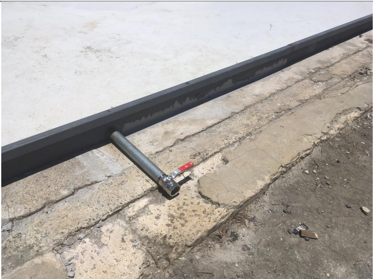
Chaque piquage est muni d'une vanne de sectionnement
