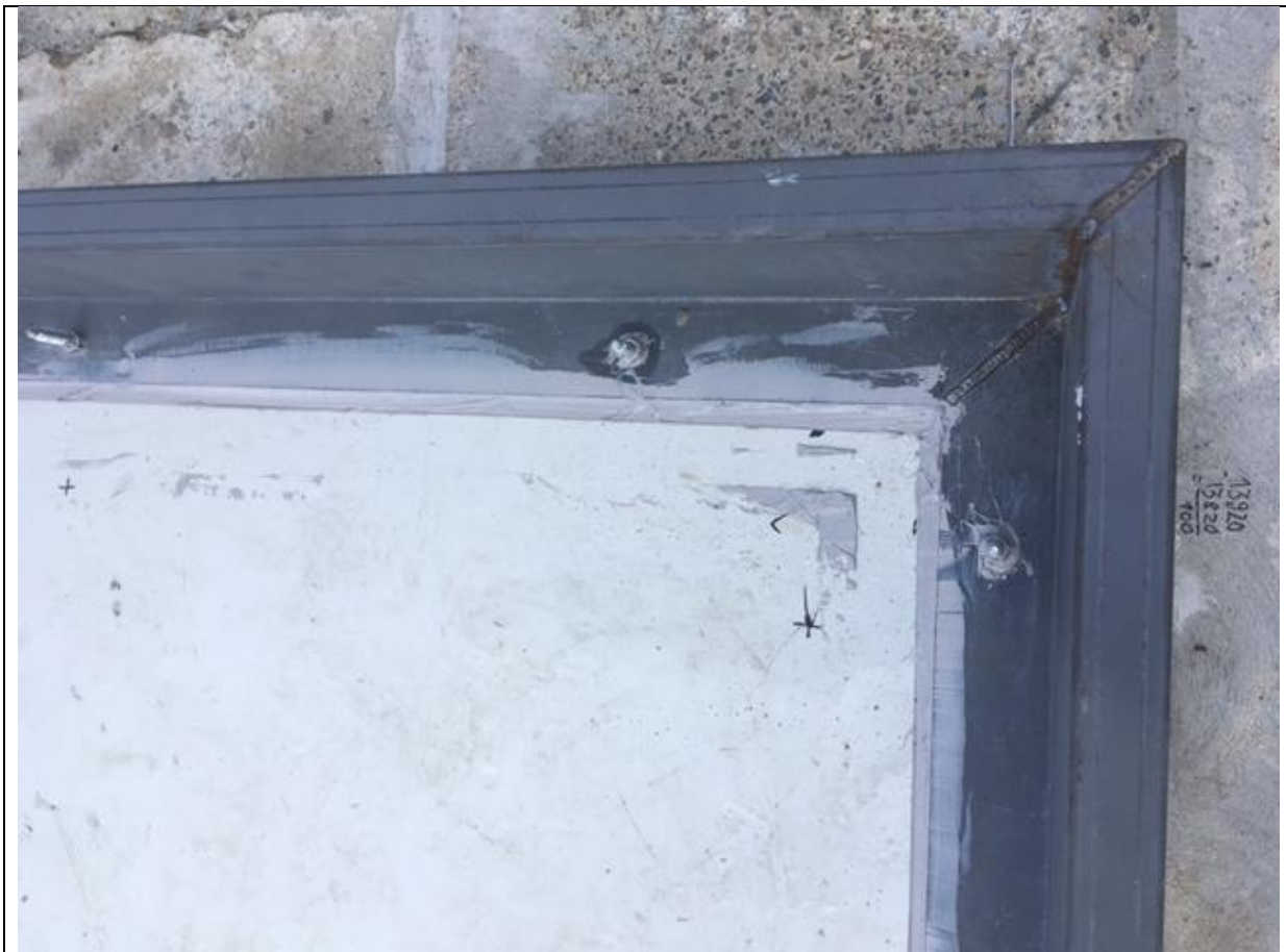
Merlons pour la rétention de la dalle (15 cm de hauteur) => capacité de rétention de 45 m 3
