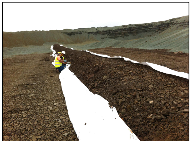
Figure 11 : Recouvrement du drain 100 par du géotextile
