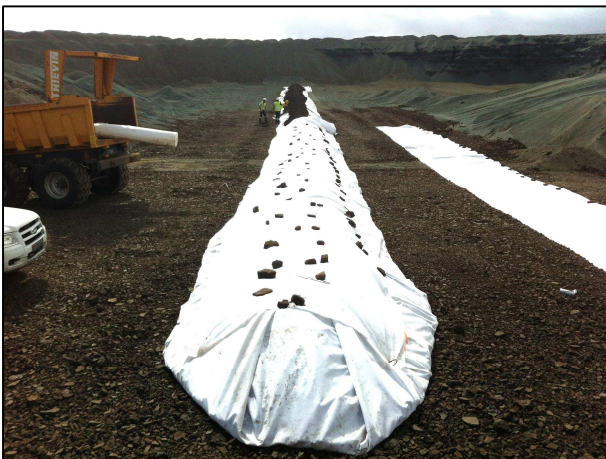
Figure 12 : Fermeture du drain 100 par du géotextile
