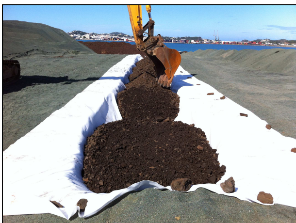
Figure 16 : Remplissage du drain 101 en Bessemer
