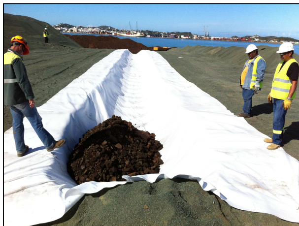
Figure 15 : Pose de géotextile au fond du drain 101
