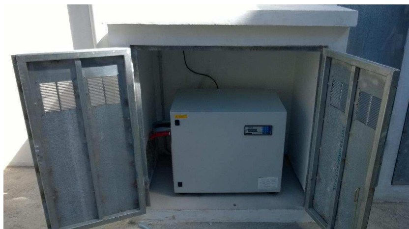
Armoire de pilotage dans son muret de protection en béton
