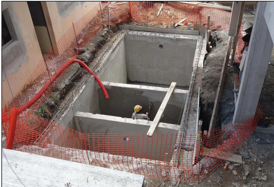
Station de traitement en cours de construction (sous parking) Résidence TAMAHÉRE (85 EH) – Nouméa - Nouvelle-Calédonie
