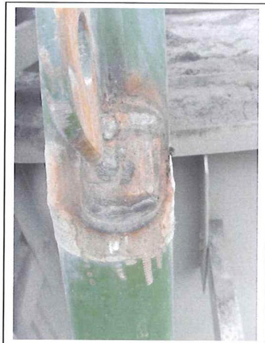
Photos 4 & 5 : Patch fait sur la conduite d'évacuation des cendres de l'ESP vers le silo à cendres.
