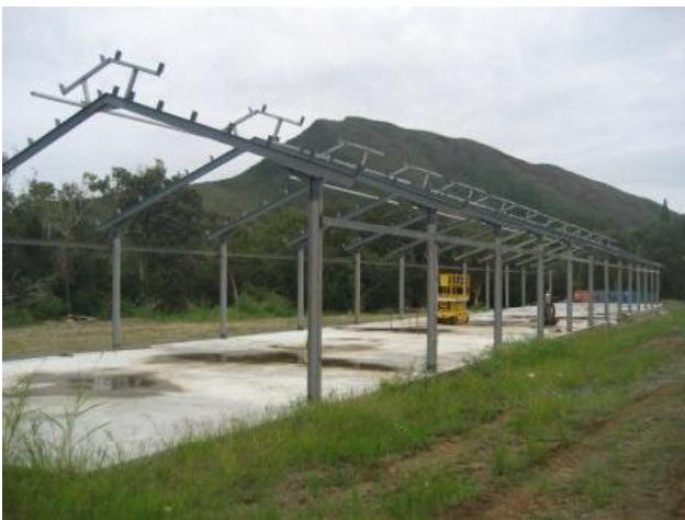
Bâtiment pondeuses en construction
