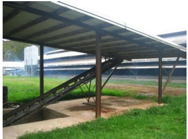
Emplacement benne – évacuation fientes (bâtiment pondeuses)
