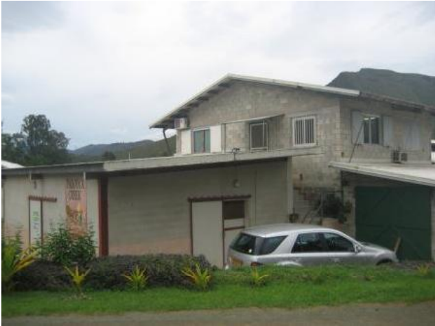
Bureaux et salle de conditionnement
