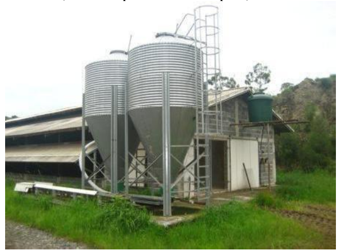
Silos et réservoir d'eau d'un bâtiment poulettes
