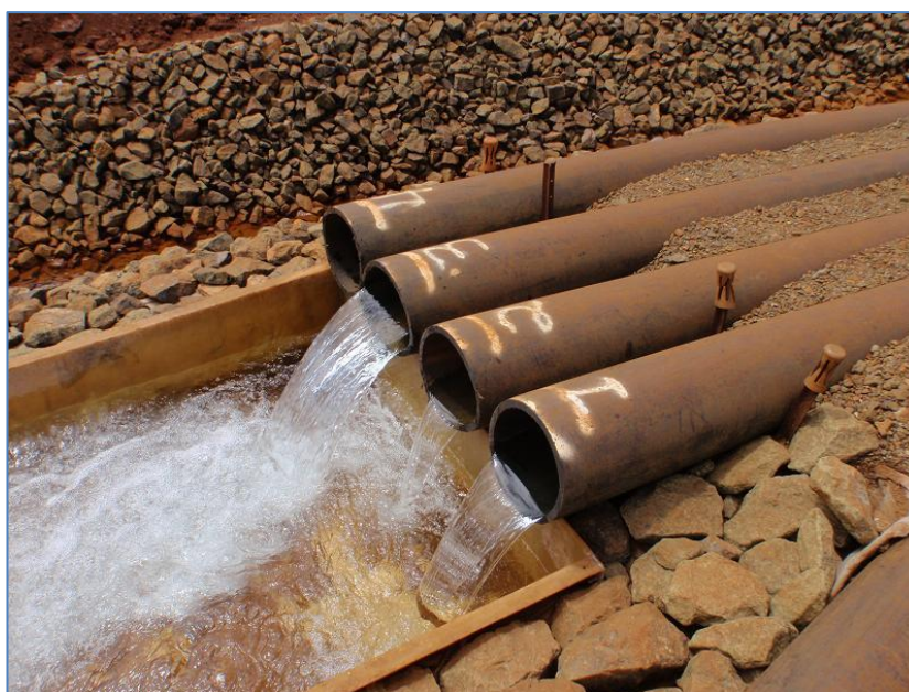
Figure 3-3 : Sortie des drains sous la géomembrane hors du puits de pompage
