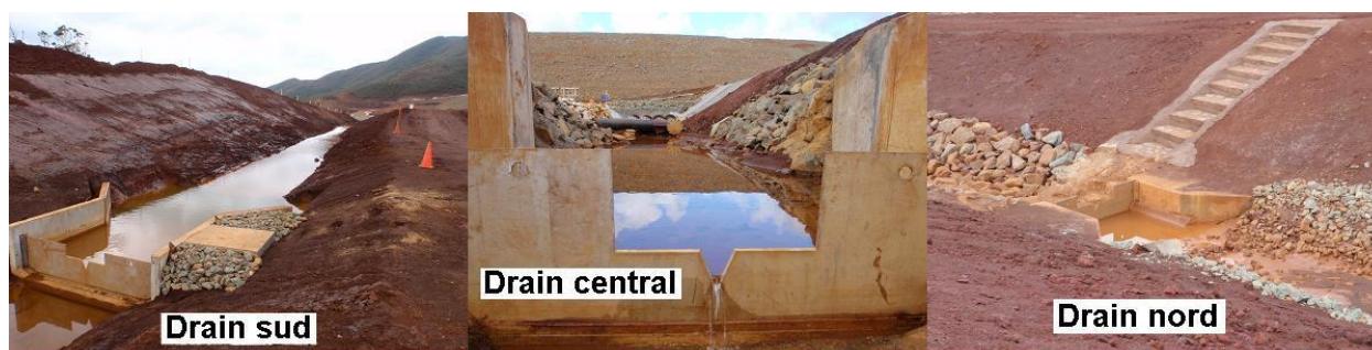
Figure 3.5 : déversoir des drains aval de la berme
