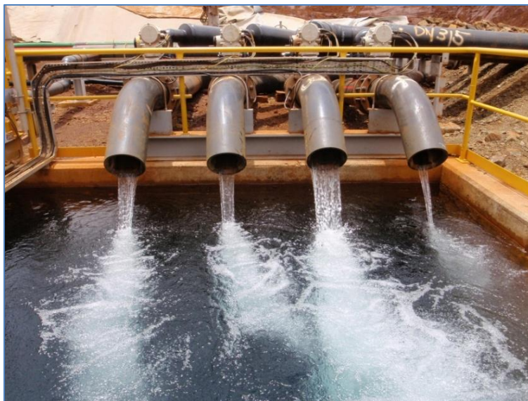
Figure 3-2 : Arrivée des drains sous la géomembrane au puits de pompage aval
