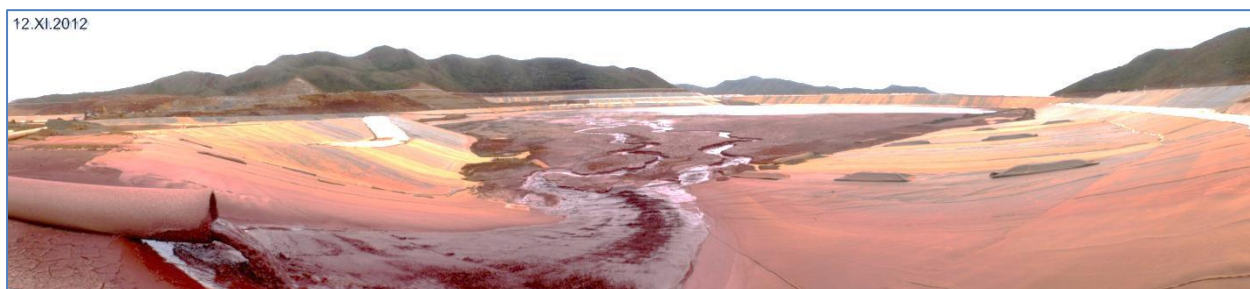
Figure 2-1 : Point de déposition et sa plage de résidus
