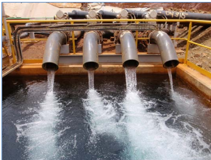
Figure 3-3 : Arrivée des drains sous la géomembrane au puits de pompage aval
