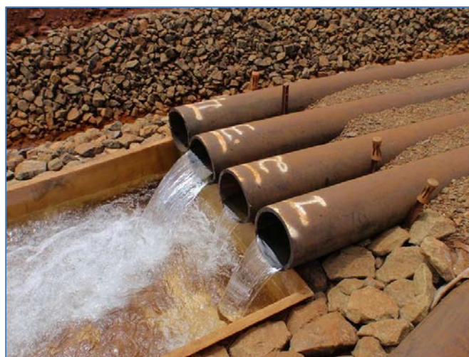
Figure 3-4 : Sortie des drains sous la géomembrane de bonne qualité hors du puits de pompage
