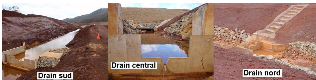
Figure 3-6 : Déversoirs des drains du tapis drainant de la berme
