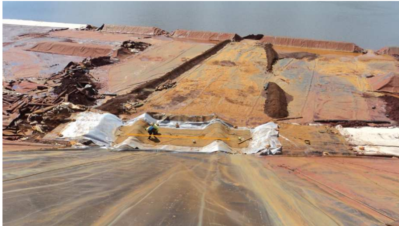
Recouvrement de la géomembrane et de son géotextile par une bande de convoyeur
