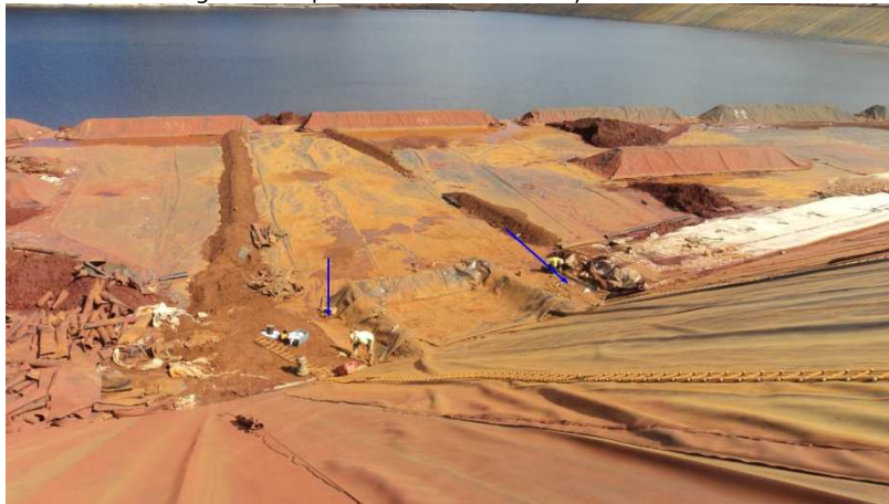
Recouvrement de la géomembrane et de son géotextile par une bande de convoyeur
