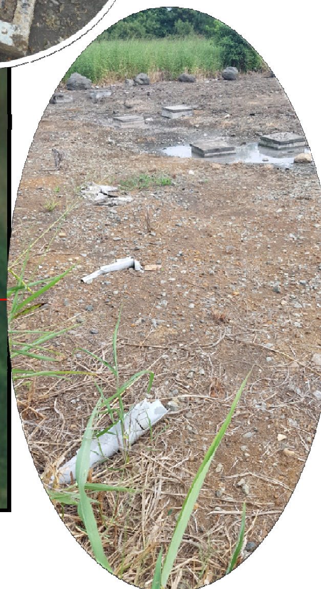
Le champ d'épandage vétuste et détérioré (tuyaux PVC et regards non fonctionnels)
