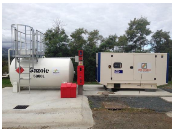
Figure 9 : Groupe électrogène et cuve de gazole.
