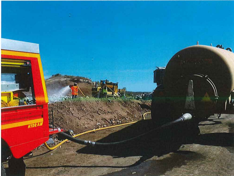
Photos 3 et 4 - Mise en place de la terre en couverture
